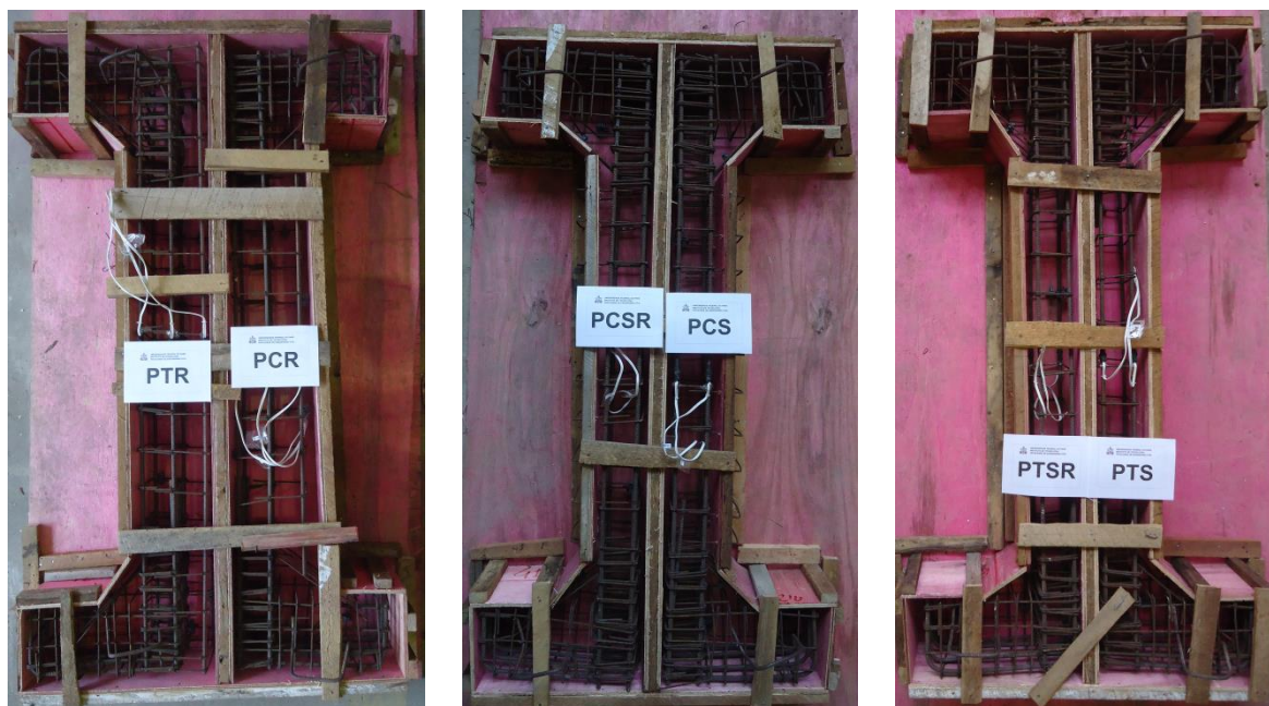
Figura 3.27 – Fôrmas utilizadas na moldagem dos pilares
