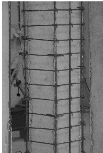
(a) Aumento de seção transversal (JULIO et al. ,2003)
